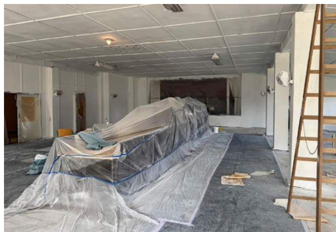
Zustand des Innenbereiches während der Malerarbeiten
