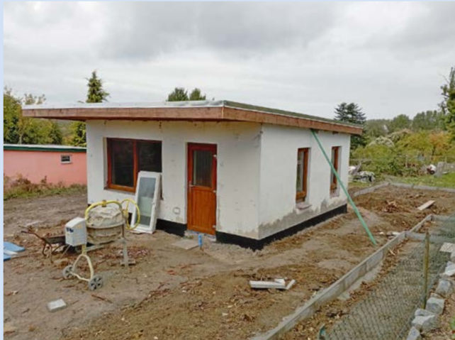
Die Gartenlaube während der Sanierung
