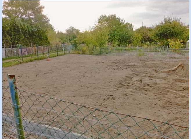
Auftragung von Mutterboden
