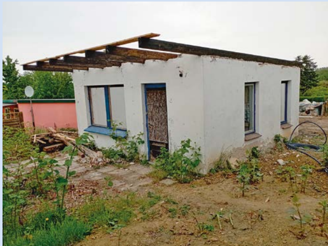
Die Laube vor der Sanierung
