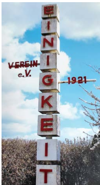
Pylon in altem Zustand
