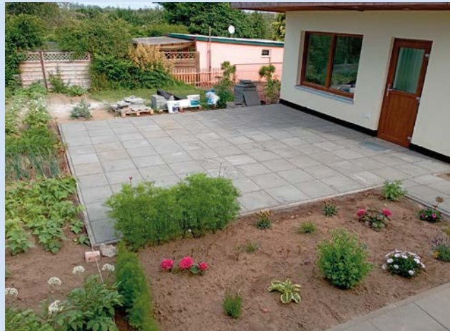
Die Laube nach der Sanierung mit Terrasse
