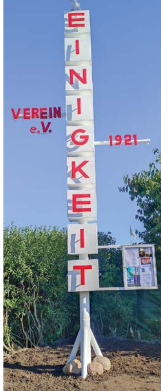
Pylon nach der Sanierung
