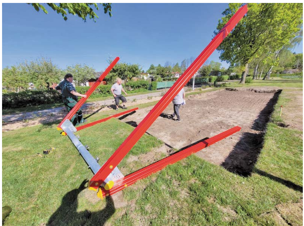
Das Schaukelgerüst wird in Position gebracht
