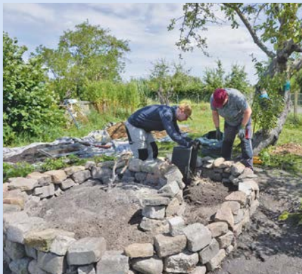
Schmetterlingsspirale im Bau
