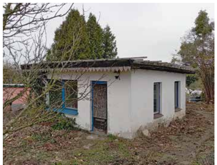
Die zu sanierende Laube
