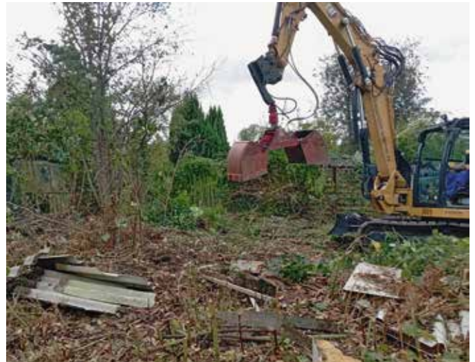
Der Bagger arbeitet sich voran
